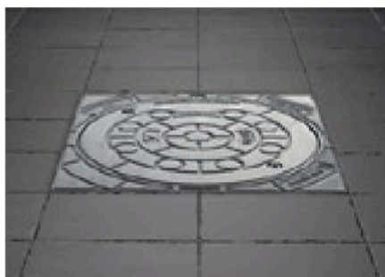
Čtvercový šachtový poklop (litina), třída B 125, 35 × 35 cm
