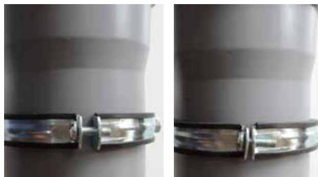
Přitažená a uvolněná objímka
