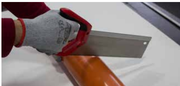
Obr. 18 Řezání trubky
