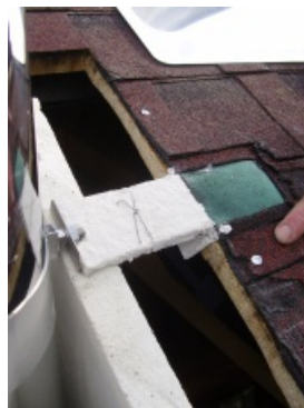
Příklad uchycení střešního držáku
