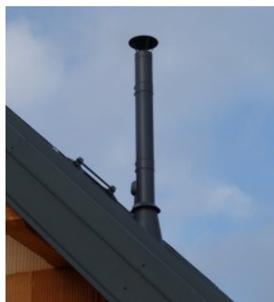
Nerezový komín lakovaný podle odstínu krytiny
