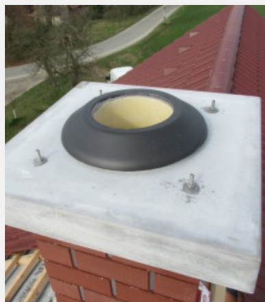
Příšroubovaná krycí deska pro přívod vzduchu
