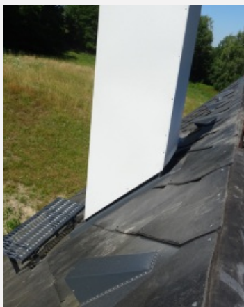
Detail přesazení návleku štuko přes lemování
