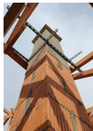
Kotvení komínu CIKO ke krovu
