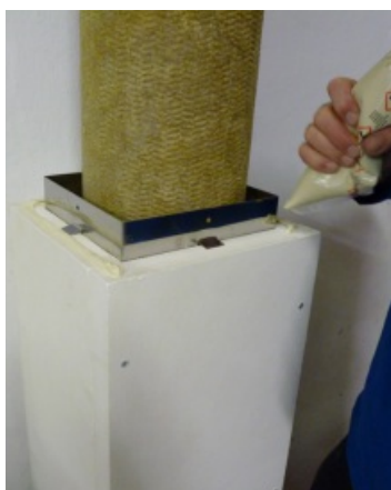
Slepování šachetních dílů COMPACT
