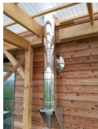
Nerezový komín založený na konzoli
