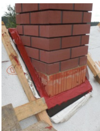
Parotěsný vstup cihelného komína
