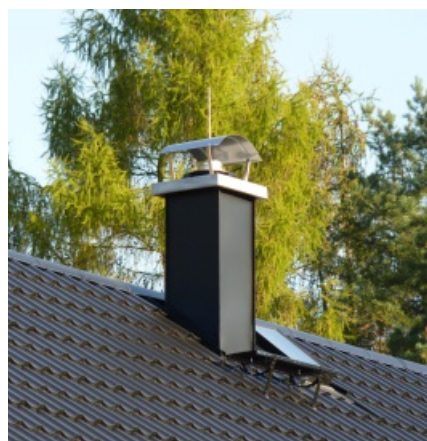
Oplechovaná základ nadstřešní část s oblou stříškou
