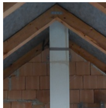
Průběžné kotvení stěnovým úchyt
