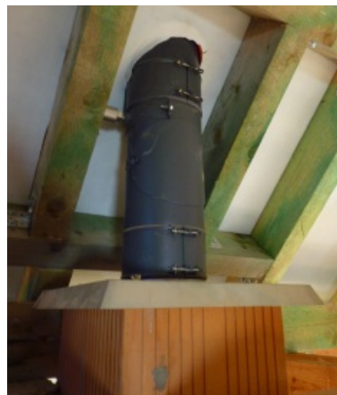
Nerezový nástavec založený pod střešou
