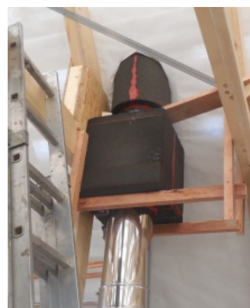
Parotěsné prostupy na nerezovém komíně
