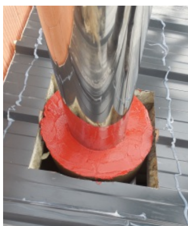
Parotěsný vstup zatřený žáruvzdorným silikonem
