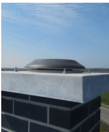
Krycí deska s přívodem vzduchu
