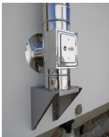
Fasádní komín na konzoli s dvířkovým dílem
