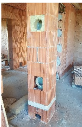
Příprava na přívod vzduchu podlahou
