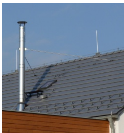
Kotvení komínu pomocí teleskopických tyčí
