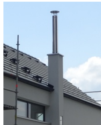
Nerezový nástavec založený nad střešou
