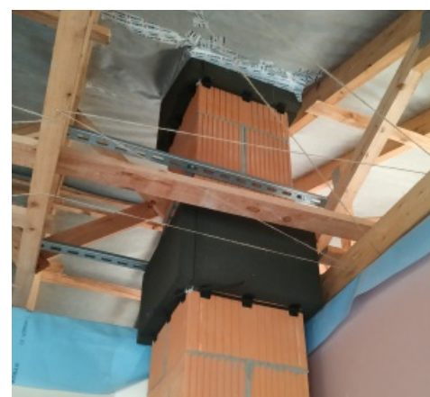
Parotěsné prostupy na cihelném komíně
